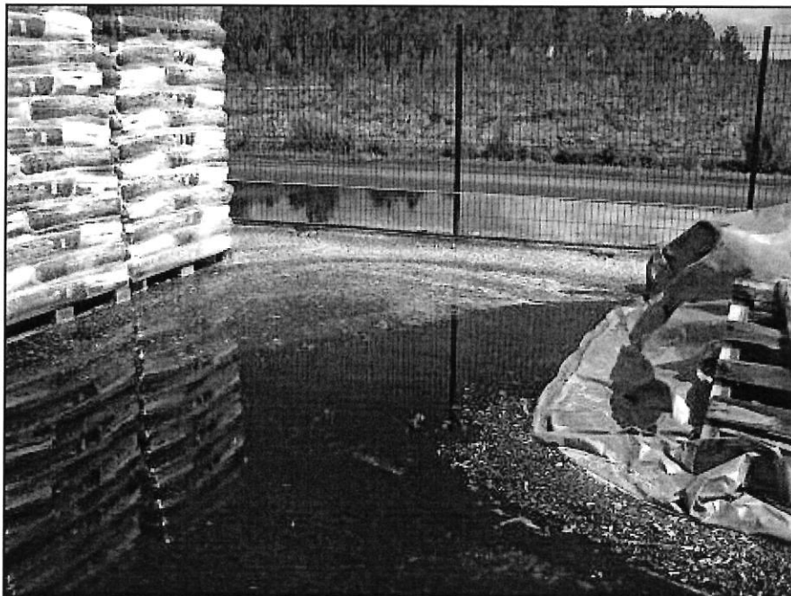
Figure 4 : Zone d'évacuation des eaux de ruissellement obstruée par des écorces (19/04/2012) (08.053.RA.002.01.fig4)
