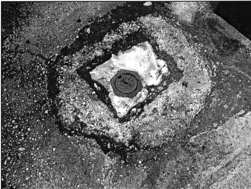
Figure 5 : Photographie de l'ouvrage PZ3 (08.053.RA.002.01.fig5)
