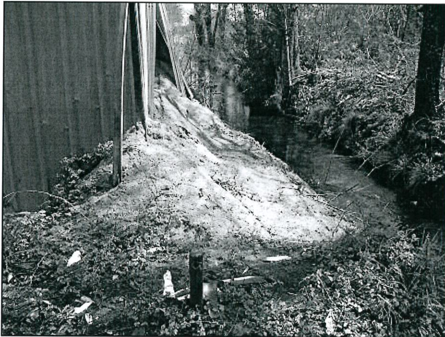
Figure 2 : Photographie de l'ouvrage PZ1
