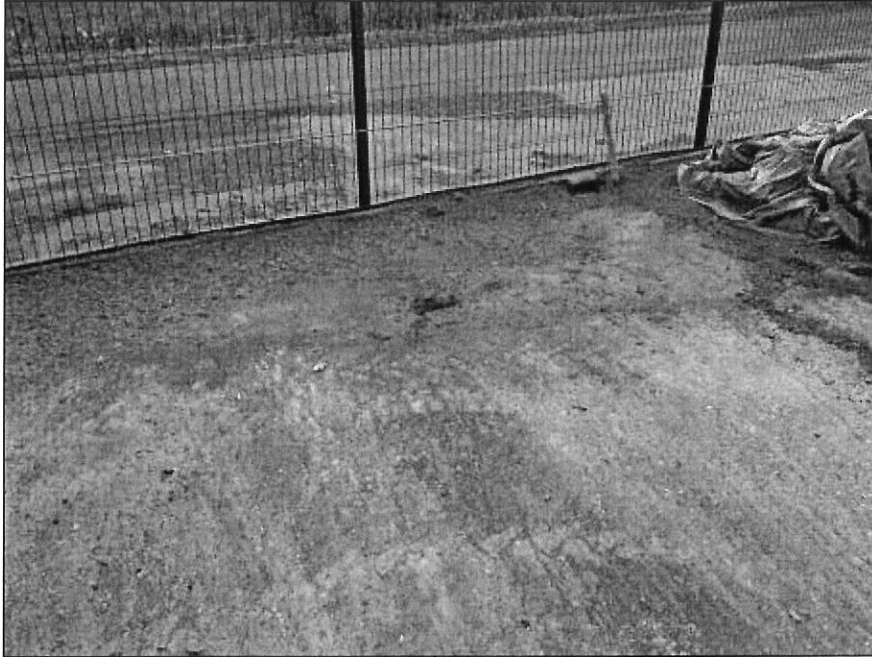
Figure n°4 bis : Photographie de l'ouvrage PZ2 (31/05/2012) (08.053.RA.002.01.fig4bis)
